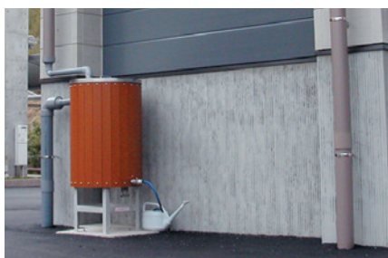
雨ボトル(雨水再利用) 建物の屋上に降り注いだ雨水を、草花への散水や洗車などに利用する為の貯水タンクです。
