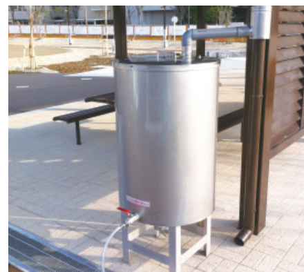
雨ボトル(雨水再利用) 建物の屋上に降り注いだ雨水を、草花への散水や洗車などに利用するための貯水タンクです。
