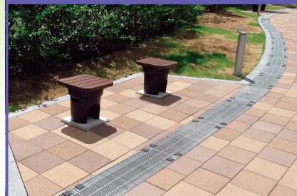
スチール製グレーチング
