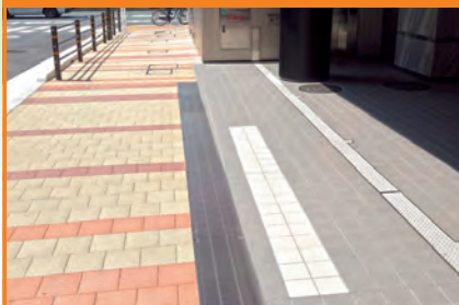
ステンレス製グレーチング
