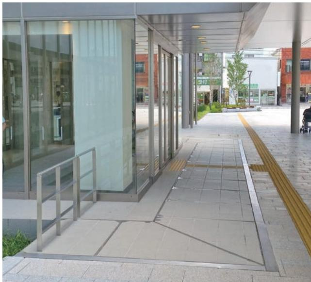
近年、建物の強度に重点をおいた耐震構造に代わり、建物下部に免震クリアランスを設け、地震時にアイソレーターおよびダンパーにより大きく変位させて、地震動から免れる、免震構造の建築物が普及しています。
