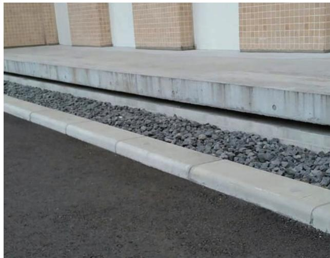
●免震建築物周りの免震クリアランスにおいて、地震で大きくX方向に広がった時に発生する開口に人が落下する危険性を無くし、X方向に大きく縮まった時には、本体が変形して破壊しない構造の床部免震エキスパンションジョイントです。
