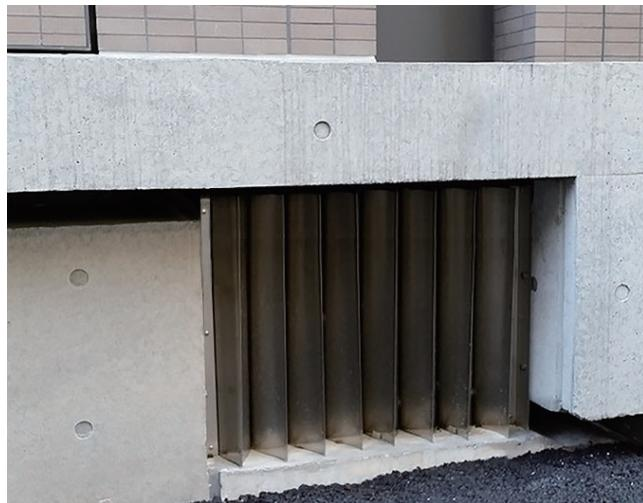
●免震建築物が、地震などで大きく変位しても、その変位に追従して破壊しない構造の免震スクリーンです。
