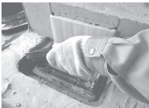
⑬ ゴム部材はマイナスドライバー等で端部を少し引き出した後、手で引っ張り上げます。
