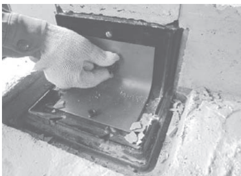
⑮ 蝶ナットを外し、固定プレートAを外します。長ネジボルトA・位置決めプレートは型枠を外す際に一緒に外します。
