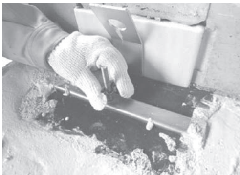
⑨ コンクリート硬化後、固定プレートBの蝶ナットを外します。
