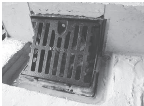
⑯ ルーフドレン本体外周の溝にシーリングを施して施工完了。ストレーナーを取り付けます。
