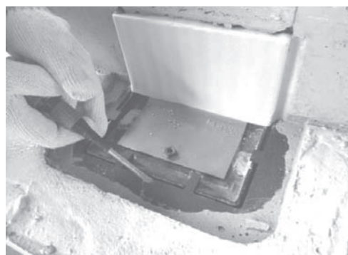
⑫ ゴム部材の切り欠き部にマイナスドライバー等を差し込み、ゴム部材R・Lを外します。
