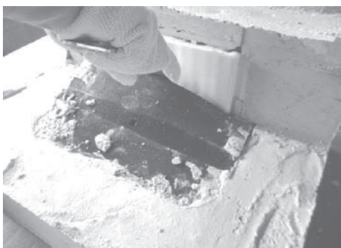
⑪ 引き上げハンドルを引上げて、抜型本体をコンクリートから外します。
