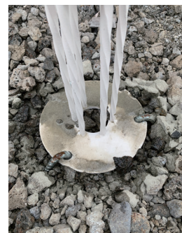
水を撒いてセメントを流し込む
