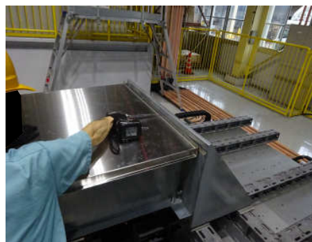
写真10 固定側本体パネル固定
