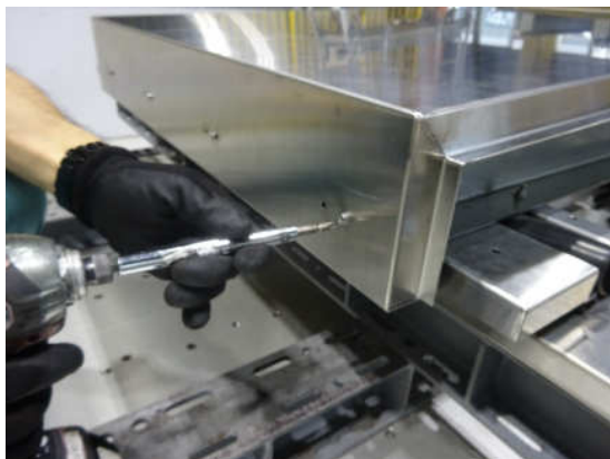
写真8 先端側本体パネル固定
