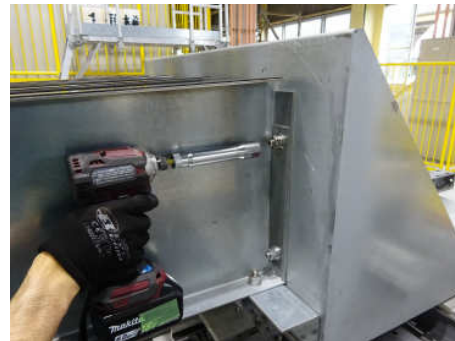
写真4 ホルダー側面固定
