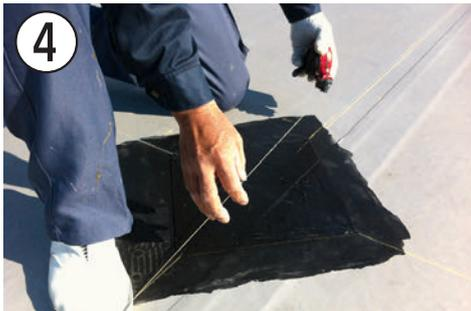
下部防水シートの上面の離型紙をはがし、①の墨出しに基づき、下部防水シートの上に再度墨出しを行う。
