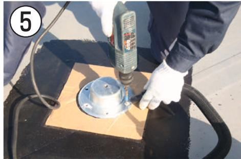
墨出しに金具上のマークを合わせながら、あと付基礎金具を下部防水シート上面に接着させ、固定穴6ヶ所に直径8mm、深さ50mmのアンカープラグ用の穴をドリルで開ける。
