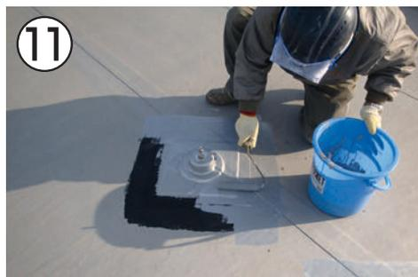
点検が終了したら、最終工程として上部防水シートの表面にトップコート塗布する。(塗布量:0.25kg/m<sup>2</sup>)
