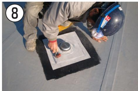
下部防水シートの上面及びあと付基礎金具の表面に、ブチルゴムシート用接着剤を塗布する。
