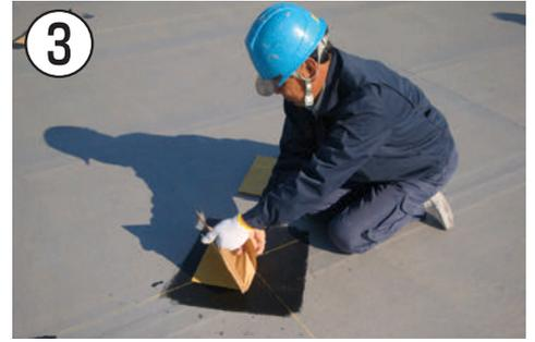
あと付基礎金具設置箇所に下部防水シートを下面の離型紙をはがしながら貼り付ける。
