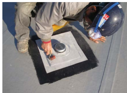
③上部防水シート貼付後、保護塗料(別途)塗付
