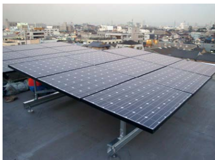
④基礎金具上に架台設置後、太陽光パネル取付
