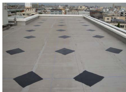
①墨出しに基づきプライマー(別途)塗布後、下部防水シート貼付
