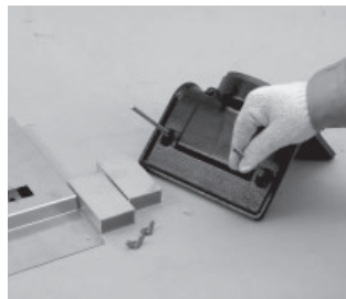
① ルーフドレン本体に長ねじボルト A をねじ込みます。
