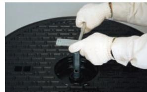
② 蓋を枠にのせ、専用開閉ハンドルを使い、六角ナットで締め付けます。六角ナットの締め付けが緩いと、水漏れの原因となります。
