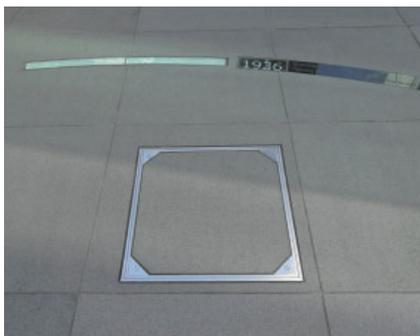
強度や耐久性に優れる、鋳鉄素材を採用した鉄蓋シリーズです。機械設備や電気設備、雨水管、汚水管等の保守点検口蓋として、さまざまな場所でご利用頂けます。
