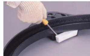
① コンクリート打設養生後、枠のロックスペースに入っている養生スチロールをドライバーなどで取り除きます。
