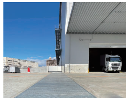
物流施設向けエキスパンションジョイント 国際海上コンテナ車などの大型特殊車両が乗り入れ可能です。長期間の使用に耐える強化構造タイプです。
