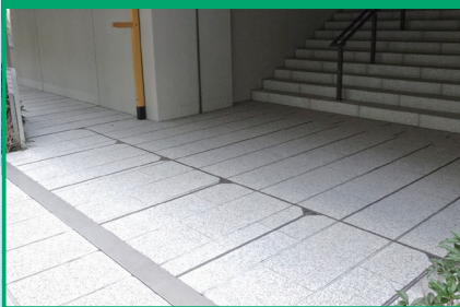
EXジョイント免震構造建築用
