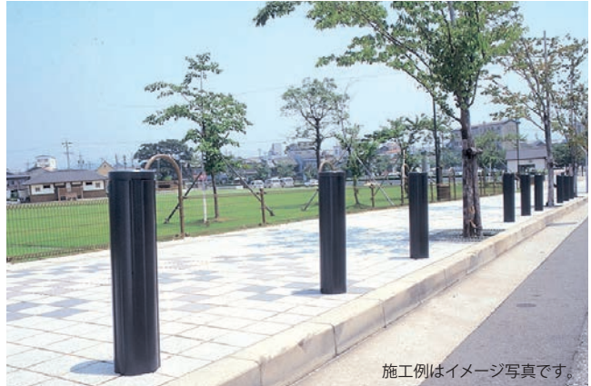
施工例はイメージ写真です。
