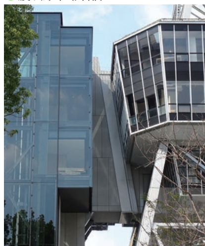
● 渡り廊下（外部）
