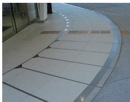
免震エキスパンションジョイント 屋外床部 曲線クリアランス対応仕様
