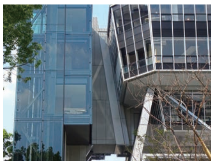
免震エキスパンションジョイント 外壁部 斜めクリアランス対応仕様
