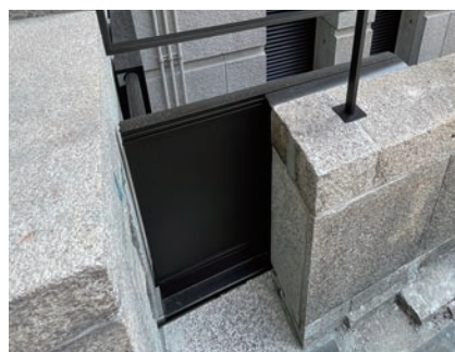
免震構造建築用 侵入防止柵 L型仕様
