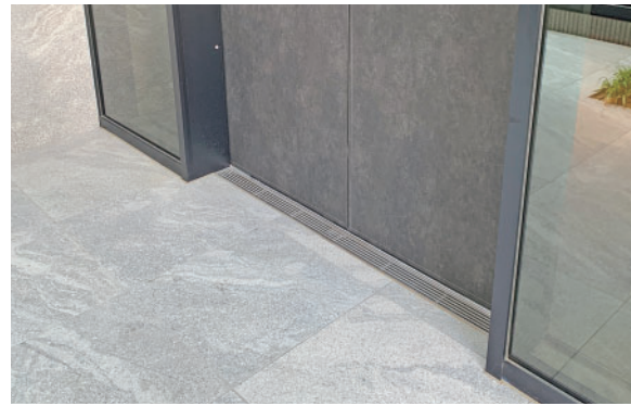
スリット寸法図 すきま6mm (P=14)
