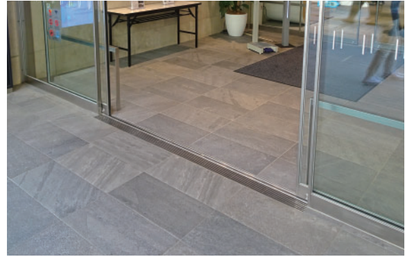
スリット寸法図 すきま6mm (P=14)
