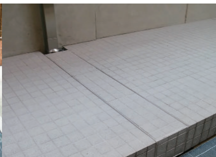
屋外床部 免震エキスパンションジョイント 曲線クリアランス対応仕様
