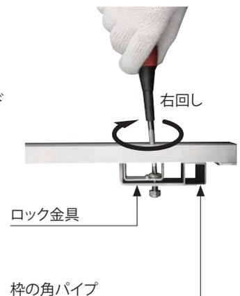
蓋の跳ね上がりやガタツキによる騒音を防止するために、スライドスクリューロックは、施工後、必ず確実に締め付けてください。
