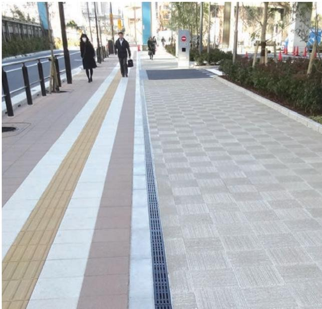
マルチスリット側溝への納まり
