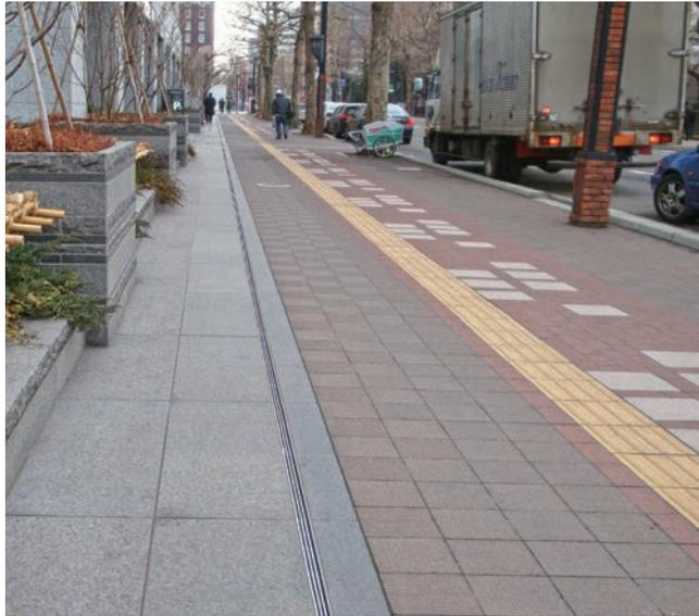
さらに細く、目立たない、スリット（開口）幅24mmのボーダースリットです。
