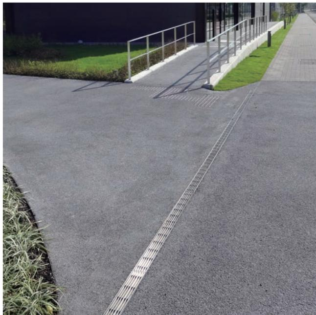
スリット蓋の跳ね上がりや、騒音防止、盗難防止のために、スリット蓋を枠にボルトで固定したボーダースリットです。
