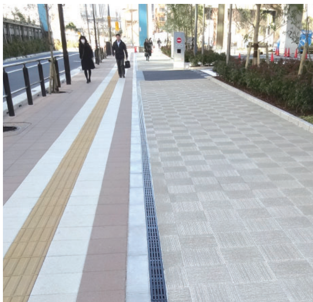
マルチスリット側溝への納まり 境界側突出なし仕様
