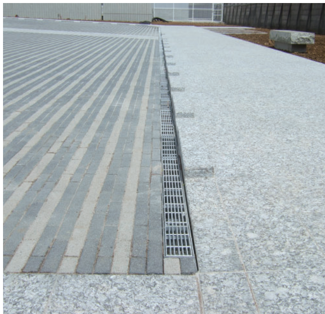
自由勾配側溝への納まり
