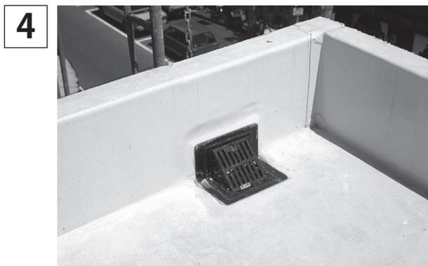
4 防水工事を施し、防水層押え、ストレーナーを本体に取り付けます。
