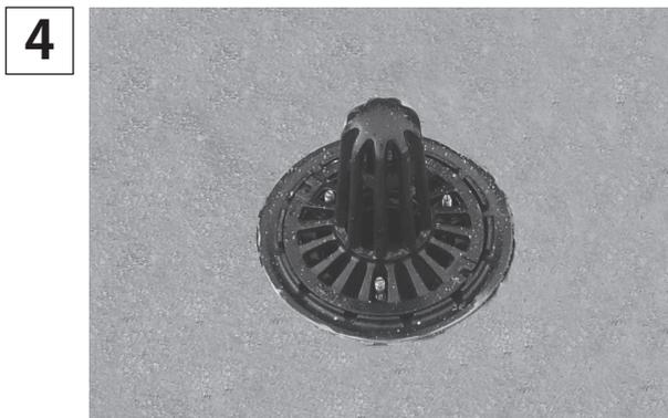
防水工事を施し、防水層押え、ストレーナーを本体に取付けます。
