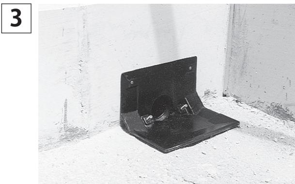
3 ルーフドレン本体を設置し、すきまにモルタルを充填し、外壁側から付属のボルト・ナットで本体を固定します。
