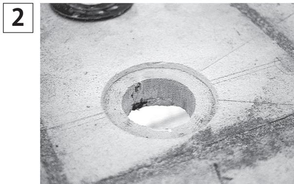
露出した鉄筋を注意深く切断した後、ルーフドレン本体つば部を受ける段差の加工を行います。
