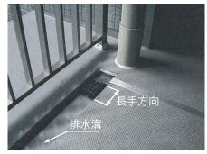
※ルーフドレン本体は、『排水溝』の流れ方向と『本体の長手方向』が、 同じ向きになるように置いてください。
