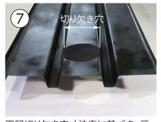
下記切り欠き穴寸法表に基づき、デッキプレート上のルーフドレン取付位置 に、穴をあけます。
