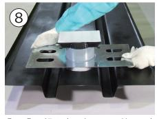
①~⑥で組み立てたルーフドレン本体および固定金具を、デッキプレート上に載せます。
