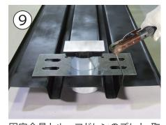
固定金具とルーフドレンのズレと、取付方向を再度確認後、デッキプレートと固定金具を溶接固定し、取付完了です。
