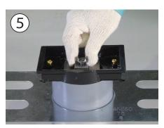
蝶ナットを長ねじボルトにねじ込み、 固定プレートと位置決めプレートで本 体、スペーサー、固定金具をはさみ込 み、一体に固定します。
