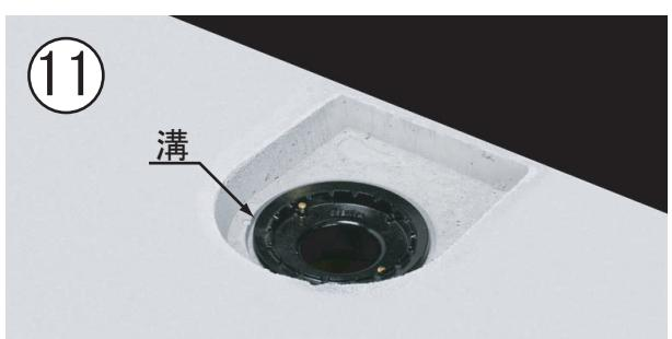
ルーフドレイン本体外周の溝にコーティングして施工完了です。ストレーナーを取り付けてください。
