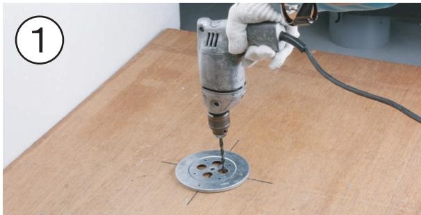
型枠に十字線を引き、位置決めプレートの中心と十字線の中心を合わせ、釘を打ち付けて位置決めプレートを固定します。位置決めプレートはC寸法によって上下の向きが異なります。
