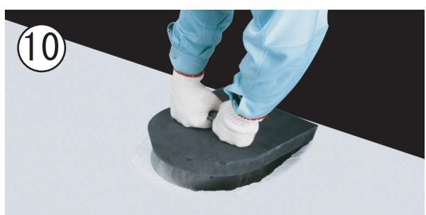
固定プレートを持ち、リングごと抜型本体を引き上げコンクリートから外してください。
