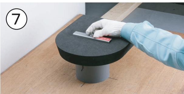
固定プレートを長ネジボルトに通し、蝶ナットをねじ込み固定します。この時、固定プレートの向きに注意してください。
