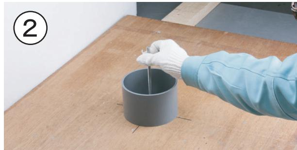
位置決めプレートに合わせてスペーサーを置き、位置決めプレートに長ネジボルトをねじ込みます。
