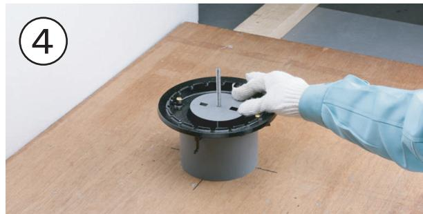
長ネジボルトに引き上げプレートをねじ込みます。
