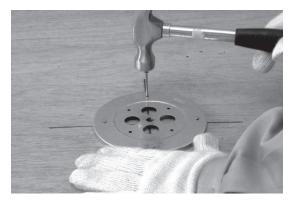
型枠に十字線を引き、十字の中心に 10mm程の水抜き用の穴をあけます。 位置決めプレートを、十字線の中心と 合わせ、釘を打ちつけて固定します。
