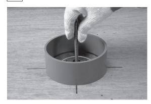
位置決めプレートに合わせてスペーサーを置き、長ねじボルトを位置決めプレートにねじ込みます。
