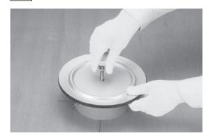
養生蓋を本体にかぶせ、蝶ナットで固定して取付完了。コンクリートを打設します。コンクリート硬化後、蝶ナットをゆるめ養生蓋を外します。 長ねじボルト・位置決めプレートは、型枠を外す際に一緒に外します。
