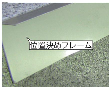
壁仕上げレベルより20mm入った位置にブチルテープを貼り付けます。貼付面の清掃を必ず行ってください。
