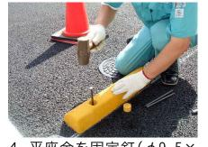
4. 平座金を固定釘(φ9.5× 200)に通し、ハンマーで釘 を打込みます。 ポンチ状のものを釘に当 て最後まで確実に打込ん でください。
