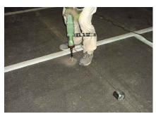
1. 設置路面上をきれいに清掃し、取付ピッチ (300mm) に従い、ドリルで $\phi$ 22、深さ65mmの下穴をあけます。穴開け後、削り屑等はきれいに除去してください。
