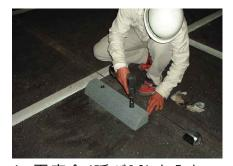
4. 平座金 (呼び16) を入れ、 六角ボルト (M16×70) でタ イヤ止め本体を締め付け ます。
