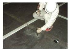
2. あと施工アンカーめねじ タイプ (M16) を 1 で開けた 穴に打ち込みます。 この時、アンカーがG. L. より突出しないよう注意 してください。
