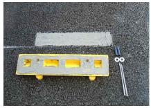
2. ウレタン系接着剤 (※) を本体裏面および設置面に全面均一に塗布します。 下穴と固定用穴がずれないように貼り合わせ、木槌等でよく圧着してください。
