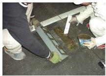
3. ウレタン系接着剤(※)を本体裏面および設置面に全面均一に塗布します。アンカー位置と固定用穴がずれないように貼り合わせ、木槌等でよく圧着してください。
