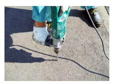
1. 設置路面上をきれいに清掃し、取付ピッチ (300mm) に従いドリルで Ø 10、深さはアスファルト層を貫通する程度の下穴をあけます。穴開け後、削り屑等はきれいに除去してください。
