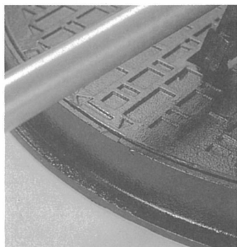
ロックがかかっている状態
