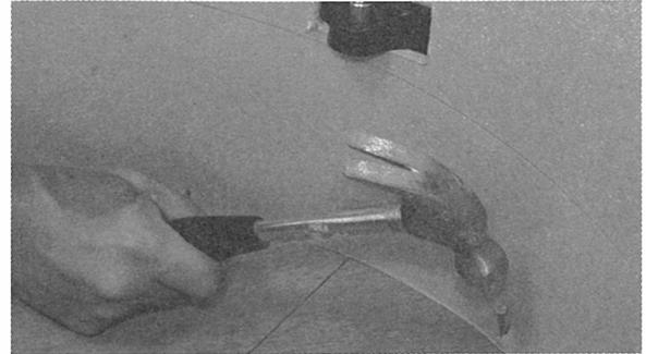
⑤ ボイド管の下からコンクリートが入らないよう、ボイド管に内側からクギを打って型枠に固定します。
