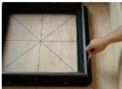
2. 受枠を開口部芯の対角線上に来るよう置き、アンカ - のボルト固定用穴位置を
