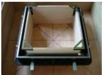
5. アンカ - を組み付けた受枠をセットし、六
