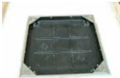
14. 枠受部を清掃し蓋をセットします。蓋にタイル等を充填し施工完了です。
