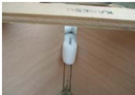
9. 型枠の角部に養生材Bを挿入します。
