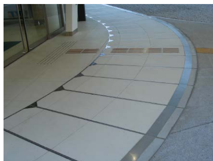
免震エキスパンションジョイント 屋外床部 曲線クリアランス対応仕様
