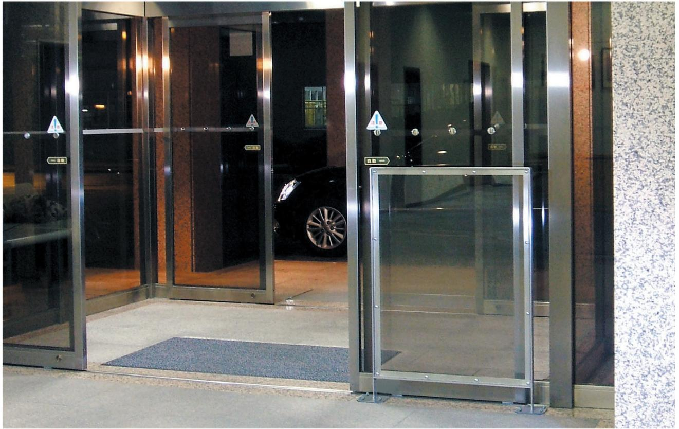
自動ドアが開く時の可動範囲部に人が侵入したり、荷物を置かないようにするための防護柵です。建物のエントランスにふさわしい質感と、安全性を確保するための強度・寸法を採り入れた自動ドアガードです。
