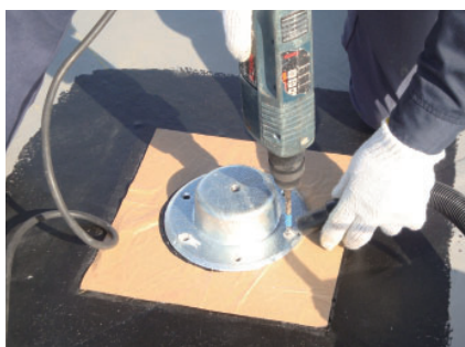
②スラブコンクリートに穴を開け、金具本体をアンカープラグ固定(6ヶ所)
