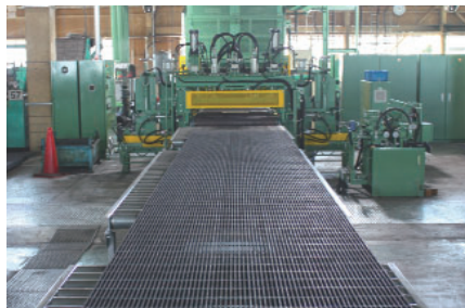
スチール製グレーチング生産設備
