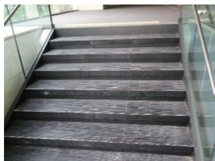
鋳鉄製 階段踏板 滑り止め模様付
