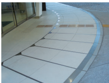
屋外床部 免震エキスパンションジョイント 曲線クリアランス対応仕様
