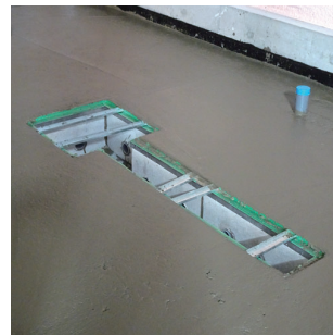
③コンクリート打設 受枠に養生カバー・幅決め材を取り付けて、コンクリートを打設します。
