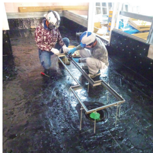
①受枠設置・レベル調整 受枠アンカーに取り付けたボルトを回してレベル調整します。
