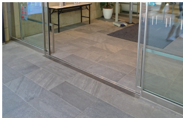
スリット寸法図 すきま6mm (P=14)
