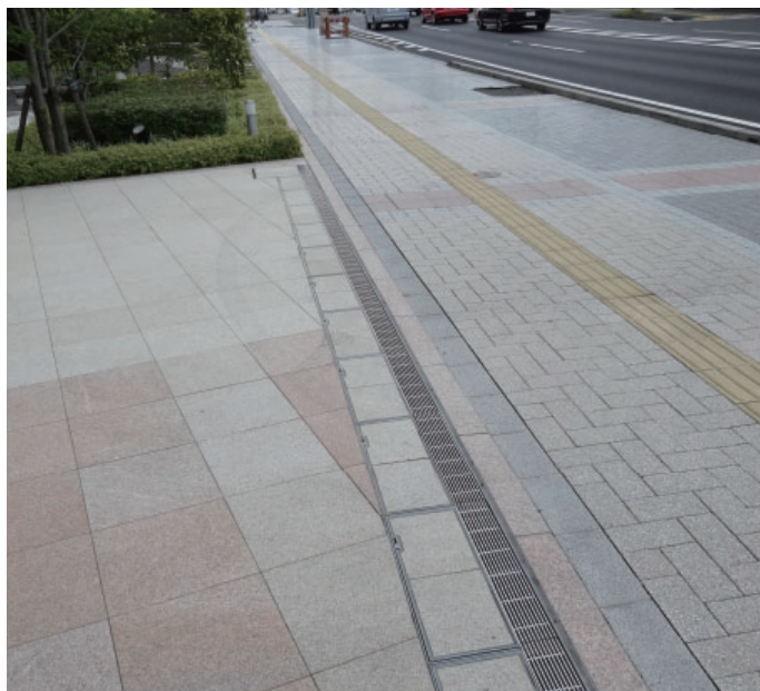
上ふた式U形側溝への納まり 掃除口 連続敷設
