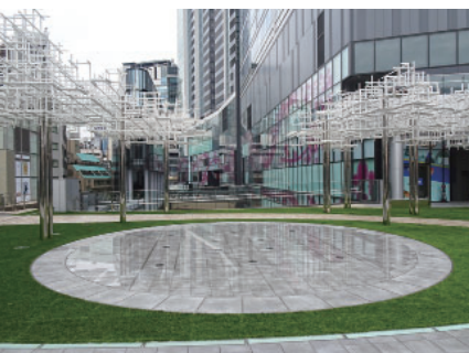
噴水吹き出し口 ステンレス製舗装材充填蓋
