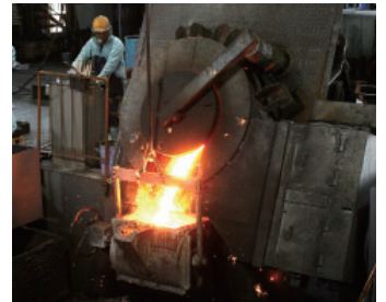
高周波誘導炉 [2.0トン炉]
